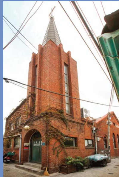
리모델링 이전 체부동 성결교회
