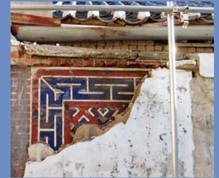
시공 중 발견된 꽃담
