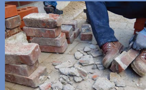
시공 중 기존 벽들 재사용 작업
