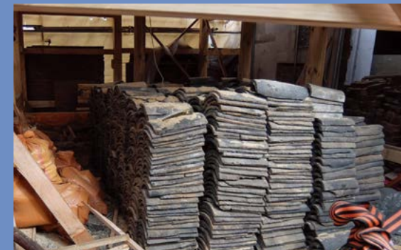
시공 중 기존 기와 재사용 작업
